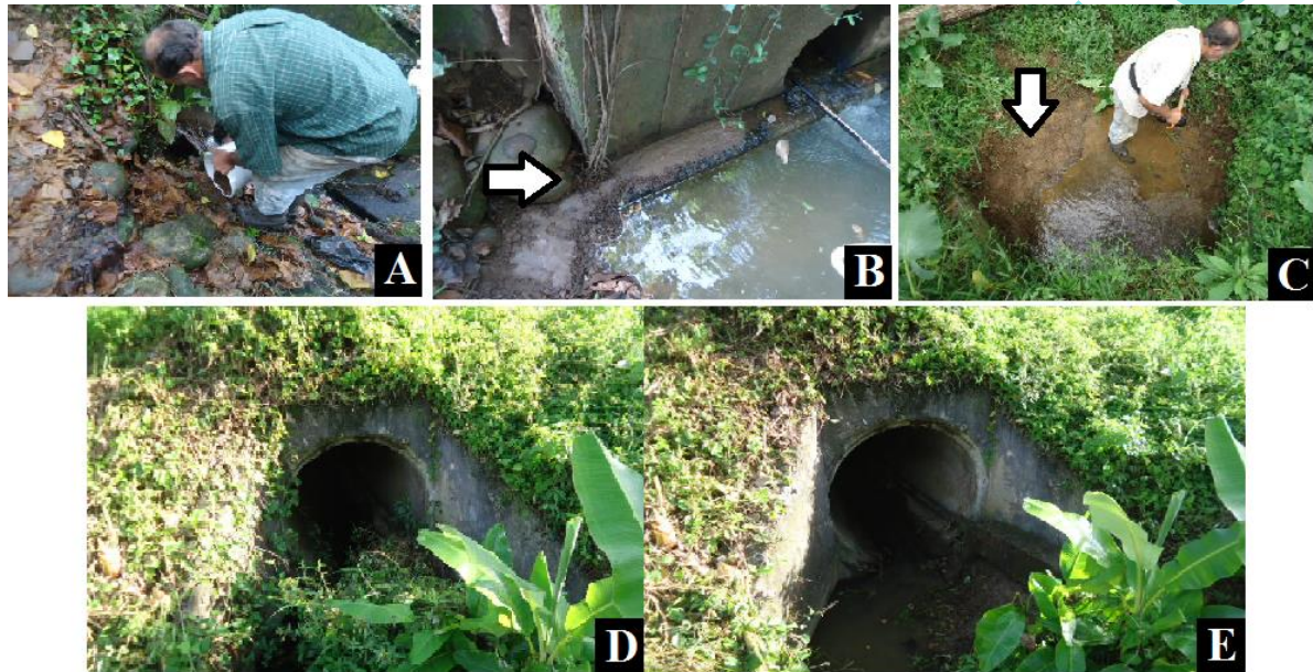
Figura 3. Ejemplos de trabajo realizado en las estructuras que no poseían sustrato apto para rastros de huellas. A. Colocación del sustrato (tierra) en la salida de una de las alcantarillas. B. Tierra colocada en la acera de la alcantarilla. C. Limpieza en la salida de alcantarilla. D y E. Antes y después de la limpieza en la entrada de la estructura de paso.
